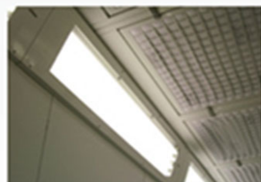
2 rijen verlichting met 4 TL-lampen 58 Watt IRC 865 ; veiligheidsglas ; IP55 classificatie 2 rangées d'éclairage avec 4 lampes 58 Watt IRC 865 et verre sécurité ; classification IP55
