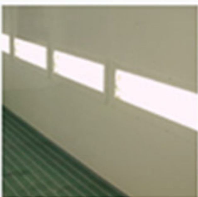
Onderverlichting in wand 3x30 Watt met veiligheidsglas Eclairage en bas de caisse de 3x30 Watt avec verre sécurit
